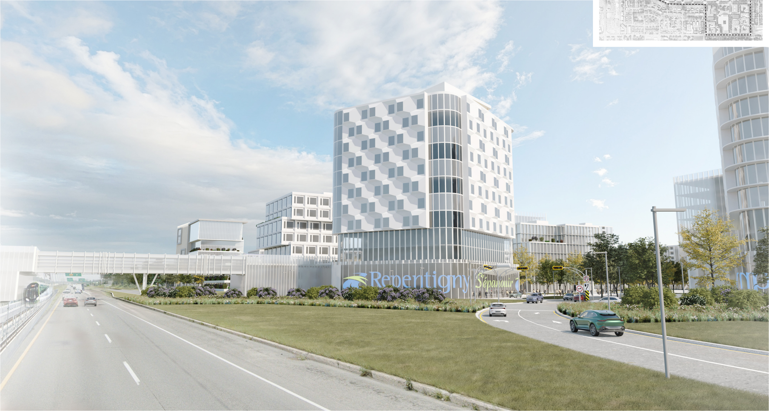
Vue du quartier Avandia à partir de l'intersection de l'autoroute 40, sortie boulevard Brien
