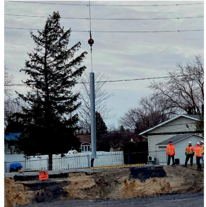
▲ Mur antibruit : installation des supports pour les panneaux acoustiques
