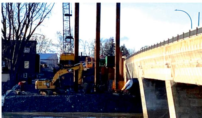
▲ Pont Rivest : construction de la culée sur la rive nord de la rivière
