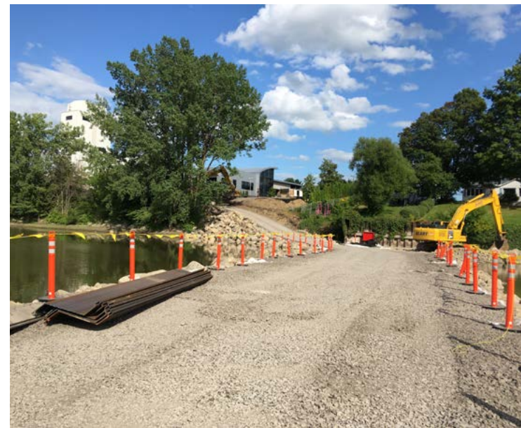
▲ Le barrage de la rivière L'Assomption durant les travaux.
