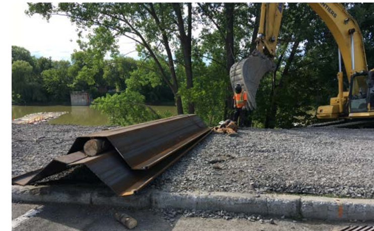
Les palplanches, plaques d'acier ondulées, sont utilisées dans l'élévation et la solidification du barrage. ▼
