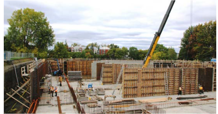
▲ Un imposant chantier qui nécessitera près d'un an de travail.
