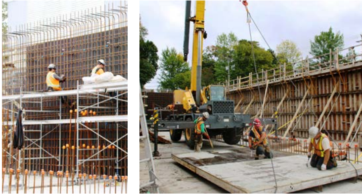
▲ Une vingtaine de travailleurs s'affairent sur le chantier de la SPE.
