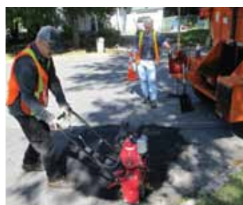
Une fois l'enrobé en place, un employé utilise un compacteur mobile pour terminer le travail.
